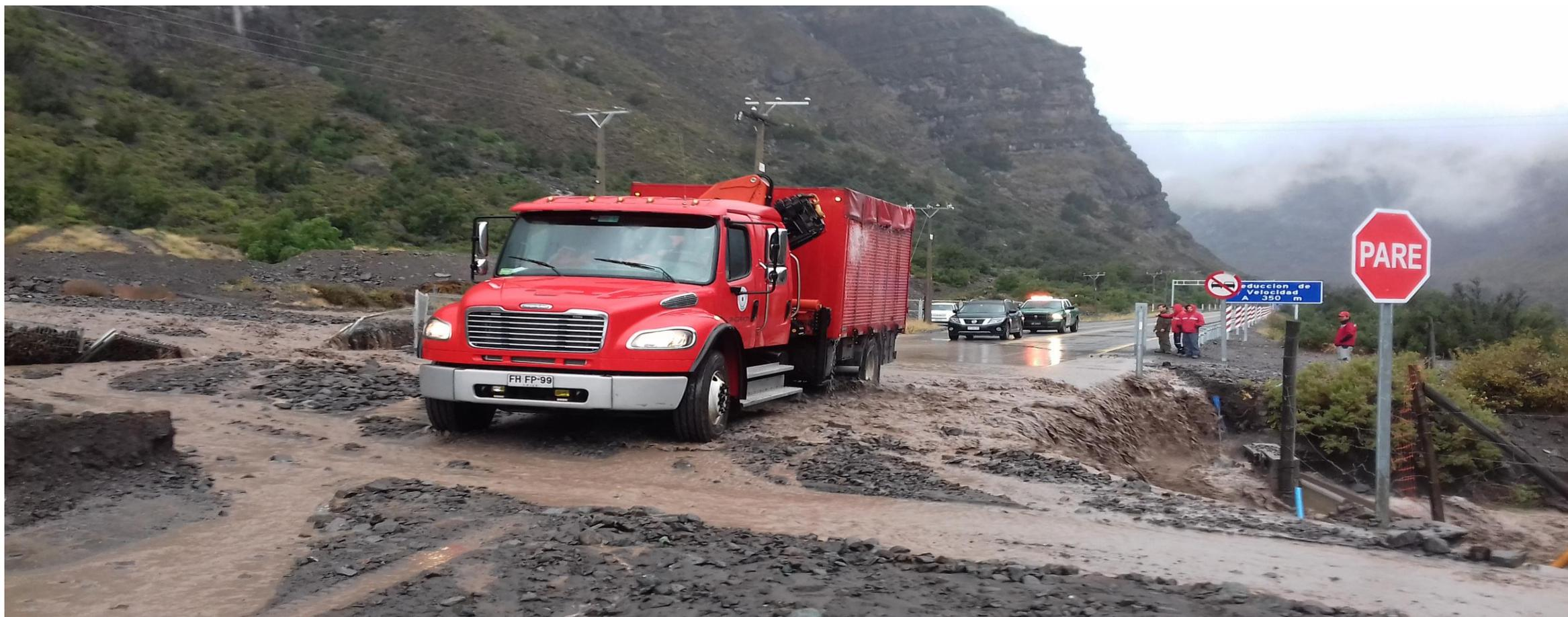
**COLAPSO DE ALCANTARILLAS POR ARRASTRE DE SEDIMENTOS**
